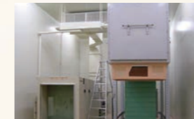
اختبار تدفق الهواء Airflow testing
